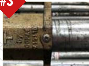
Présence de la vis anti dévissage de l'écrou
